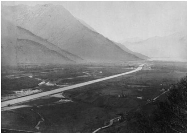
14. Parte inferiore della correzione vista da Magadino nel 1895; si riconoscono cinque traverse di colmamento sulla sponda sinistra.
