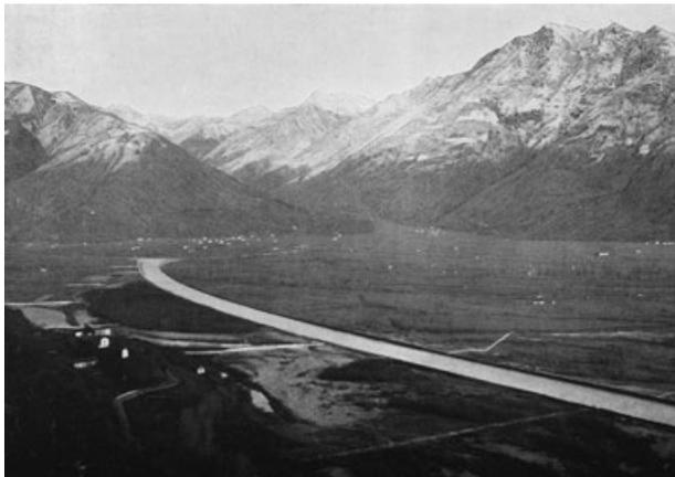
11. Parte superiore della correzione vista da Gudo nel 1895; si riconoscono sette traverse di colmamento sulla sponda destra e due sulla sinistra.
